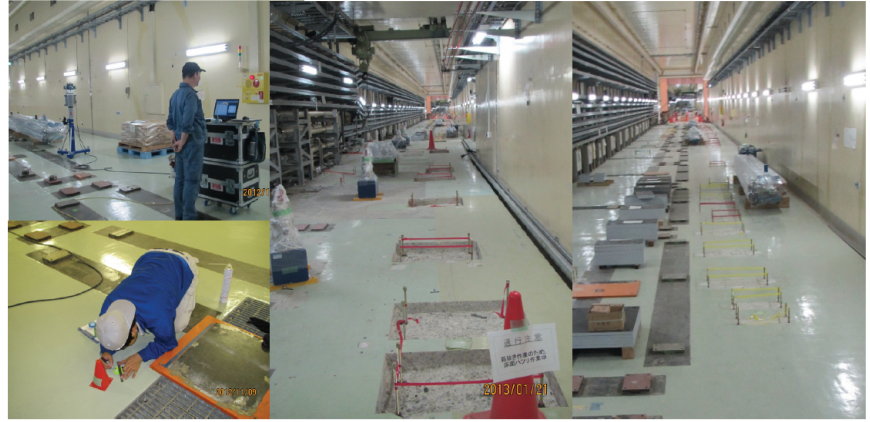
電磁石搬入・据え付けは来年度から一部の電磁石は新規製作予定
